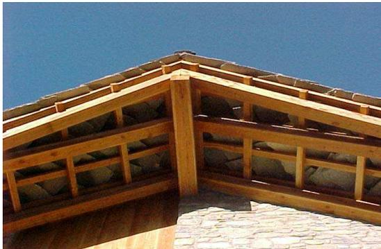
La maggior parte degli edifici antichi si presenta con pianta irregolare, imponendo alle falde di copertura geometrie particolari di non facile percezione ad un esame superficiale. Sovente, per evitare l'effetto ad "elica" delle falde, il colmo è disposto in pendenza oppure non è in asse con il fabbricato: espedienti adottati per migliorare l'estetica e la funzionalità del tetto. Un corretto rilievo permette di capire e successivamente applicare queste "regole dell'arte".
